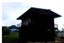
บ้านพัก ภารโรง อื่น อื่น ปีที่สร้าง 2539
