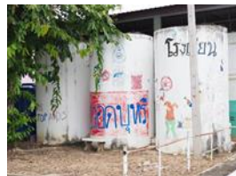
ถังเก็บน้ำ ฝ.33 ปีที่สร้าง 2541
