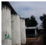
ถังเก็บน้ำ ฝ.33 ปีที่สร้าง 2539
