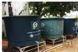
ถังเก็บน้ำ ถังน้ำใต้ดิน ปีที่สร้าง 2540
